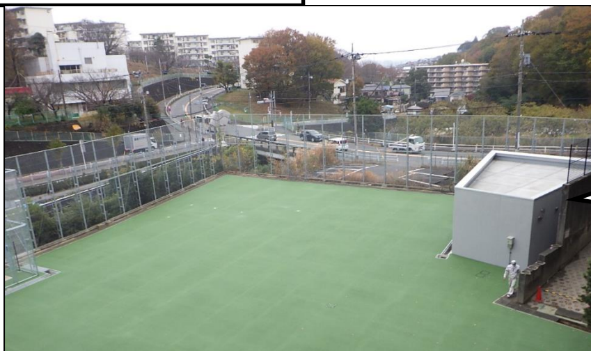
グラウンド（プール棟横）
